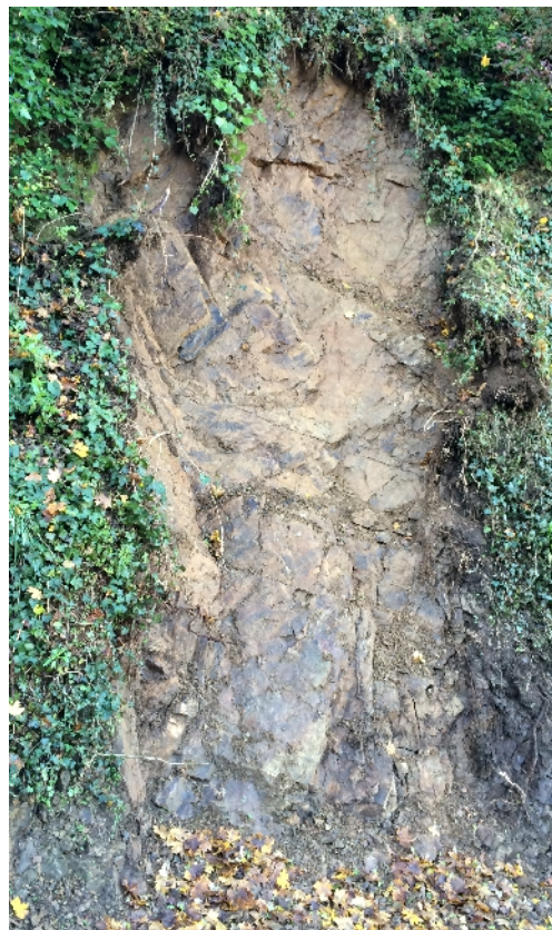
Figure n°9 : cicatrice d'un glissement rocheux sur le chemin des Jacquetières
