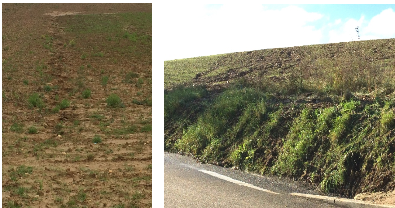
Figure n°7 : Traces de ravinements sur des parcelles agricoles de la commune
